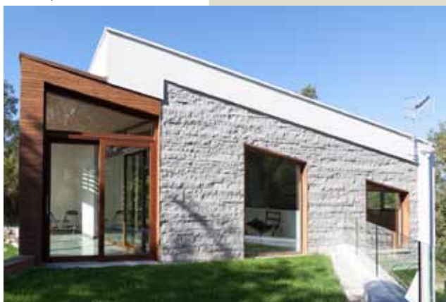
Galería Sur y Cubierta ajardinada
